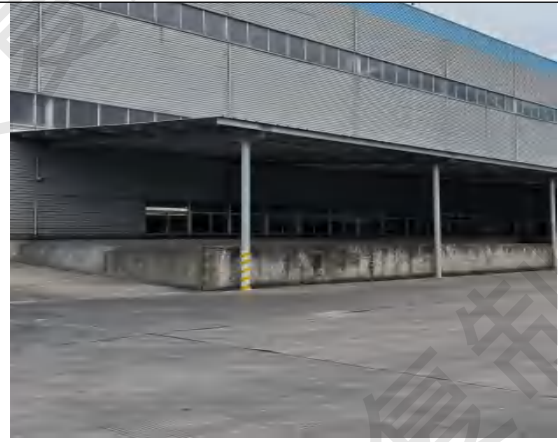
一般固废贮存间
