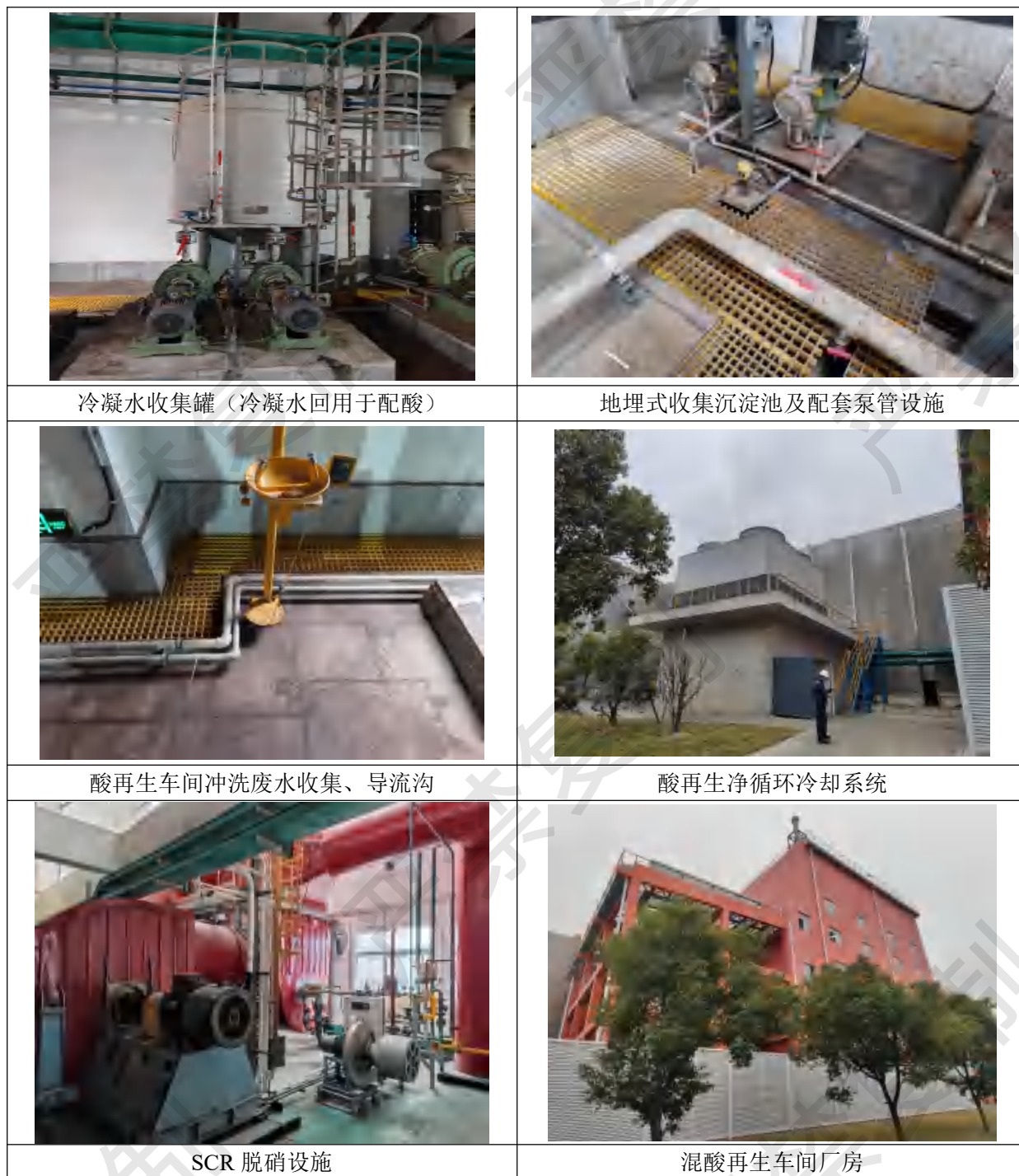
图 3.1-12 上克混酸再生系统及配套设施
