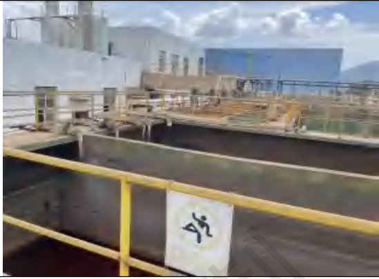
含铬废水处理设施
