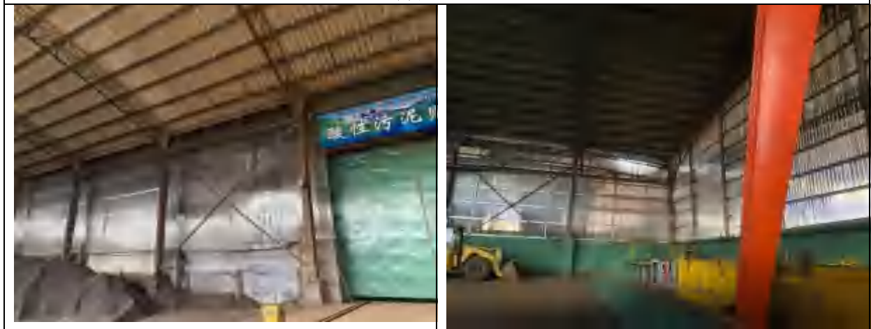
酸洗泥库（已停用）
